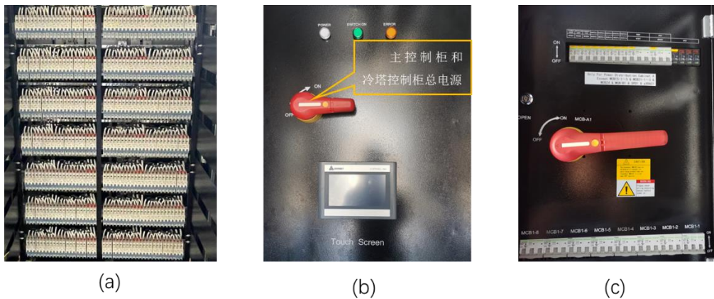
图 7-2 (a) 配电柜高算力服务器电源开关示意图 (b) 主控制柜内部示意图 (c) 配电柜总开关示意图
