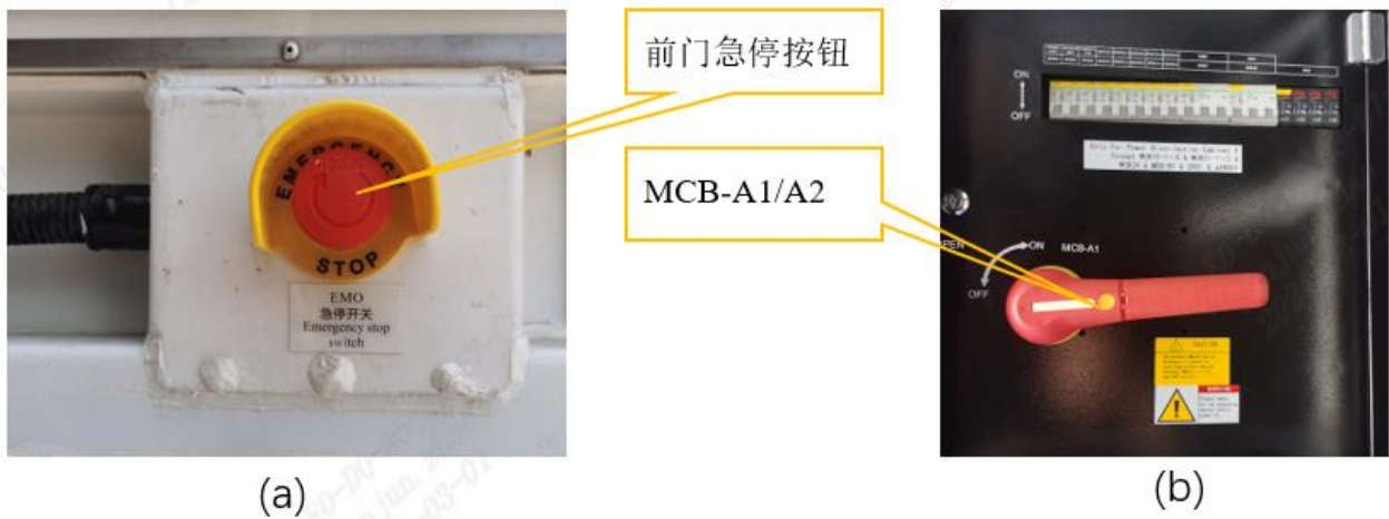
图 7-1(a) 集装箱前门急停旋钮位置
