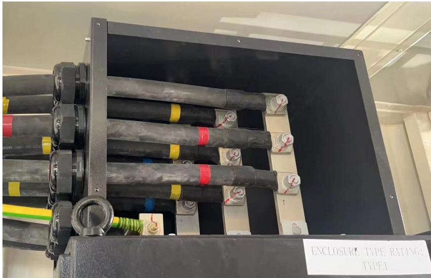
图 7-20 电缆连接示意
