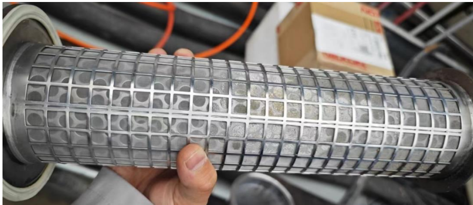
图 9-2 管道过滤器拆除示意图
